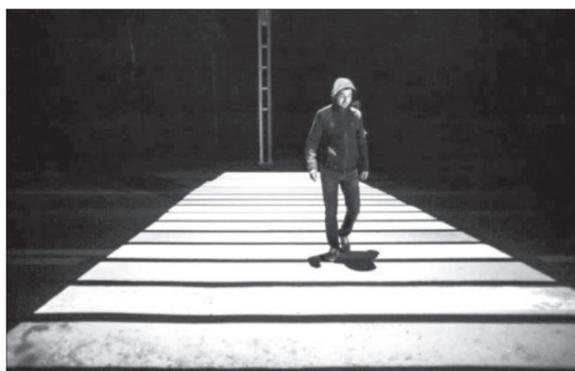
Три светодиодных проектора с цветными фильтрами размещены на п-образной опоре над нерегулируемым пешеходным переходом. Они высвечивают на дороге изображение бело-жёлтой «зебры».
